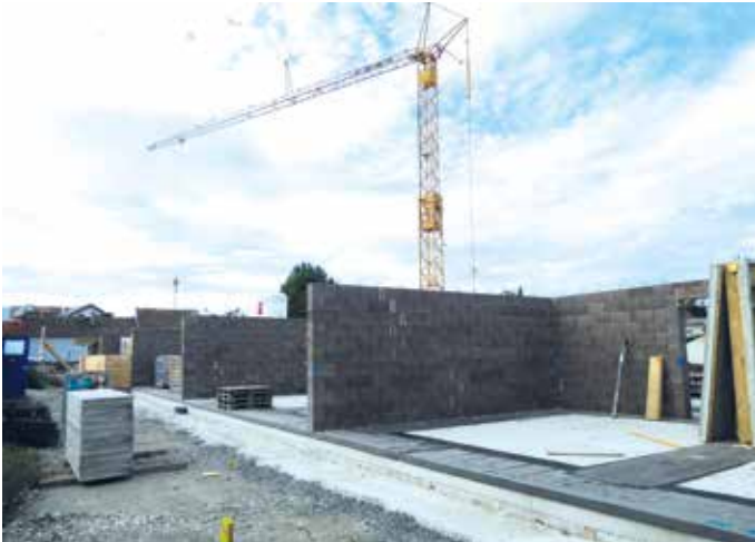
Großbaustelle im Ortszentrum von Zemendorf
