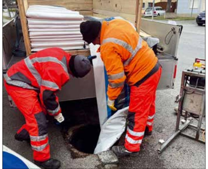
*Der mehrschichtige Schlauch wird in die Kanalisation eingeführt und mittels UV-Licht ausgehärtet.*
